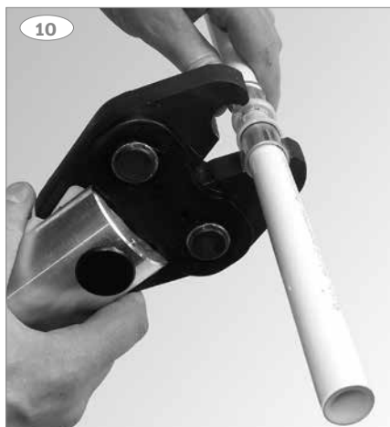
10: Placera pressbacken (för 16 - 32 mm) på presshylsan mellan plastdelen och presshylsans krage.
