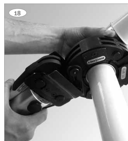
18: Placera grundbacken i pressringen och starta maskinen.
