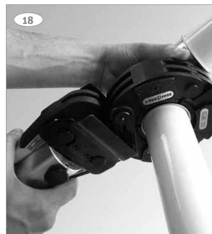
18: Placera grundbacken i pressringen och starta maskinen.
