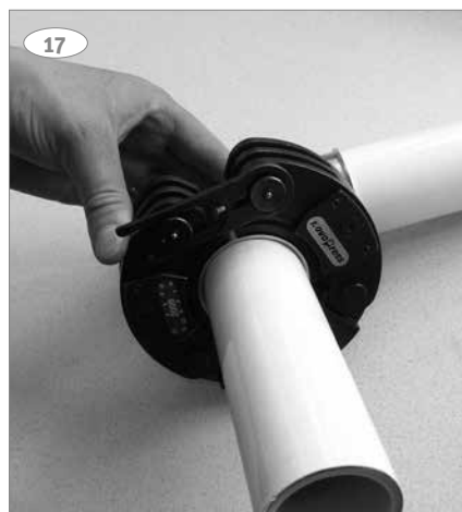
14: Placera pressringen på PressCheck®-kopplingen.
