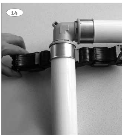
14: Placera pressringen på PressCheck®-kopplingen.
